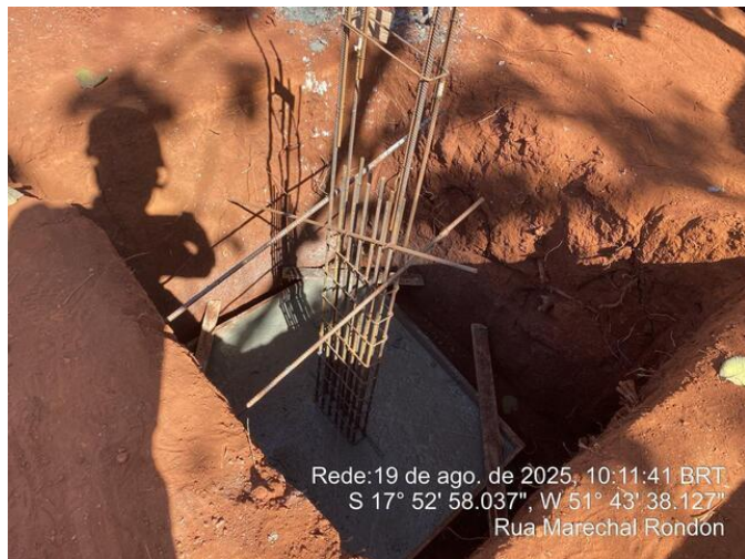
Concretagem das sapatas
